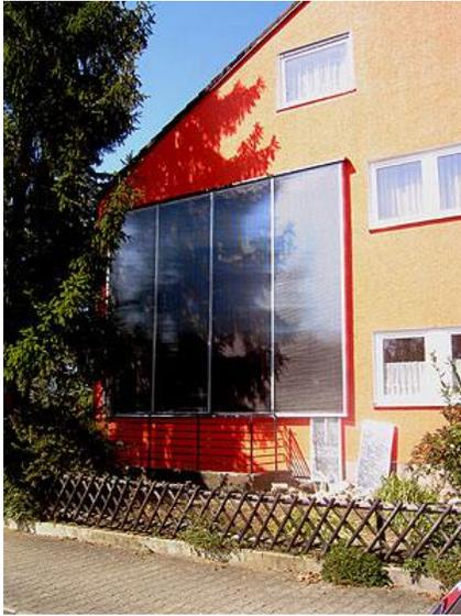
45) ...zum Fassaden-Gesamtbild als „harmonisch“ beurteilt. Die Formteile werden noch mit Holz und Alublech passend zum Kollektor verkleidet und unten mit Bauschaum zum Kellerrohr sicher und dicht abgeschlossen. Drainage aus groben Kiess sorgt für gute Abfluß von Regenwasser...
