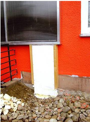
54) Zurück zum Großkollektor-Anschluß zum Keller... das Styropor-Teil wurde mit Holzbalken und Bauschaum fest und dicht gemacht. Es fällt nur noch die Alu-Blech Verkleidung...
