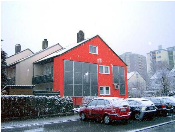
67) Auch sämtliche Schrauben der „alte Konstruktion“ wurden durch längere ersetzt... die Luftdruck-Kräfte wurden einfach unterschätzt. Querverstärkungen aus Alu-L-Profil teilen jetzt die einzelne Kolltorgelder in 3 Teile und bringen weitere Stabilität in die Statik... nun sind (hoffentlich!) alle „Kinderkrankheiten“ beseitigt... Nach Test unter „Vollast“ wurde der Gerüst nach ca. 1 Woche abgebaut (...und 150.- Euro dafür leider zusätzlich ausgegeben) – „learn by doing“ kostet leider auch Geld...
