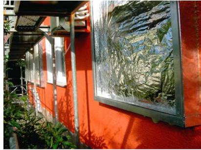
13,14)...alles dicht mit Rahmen verkleben (5cm breite Alu-Klebeband aus Saunabau).
