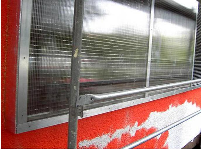
24) Zwei Tage später – ...die erste 2 Luft-Kollektorfelder wurden mit PC-Doppelsteg Platte endlich abgedeckt...
