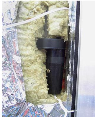
16) Absorber-Motor und die Welle werden im Dämmung eingebettet und...
